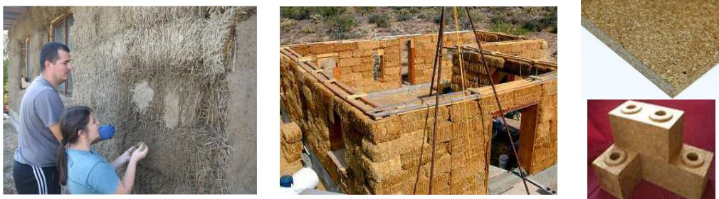
Slika 3. Izvođenje radova gradnje prve kuće od slame u BiH [14] i ploče od presane slame (izvor: [www.gradimoslamom.hr](http://www.gradimoslamom.hr)), te blokovi od rižine slame(izvor: <http://www.oryzatech.com>)
